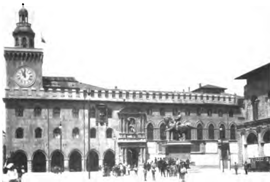
Il quadrante dopo i lavori del 1888.
